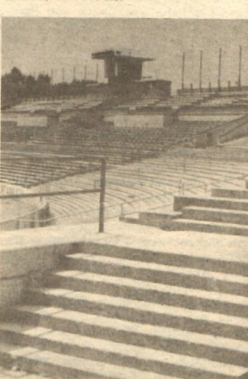
Das Dresdner Dynamo-Stadion bietet künftig bis zu 44 000 Zuschauern Platz. Noch sind die Arbeiten nicht völlig beendet, doch wird schon in der kommenden Saison die erweiterte Kapazität den Besuchern der Dresdner Spiele zugute kommen. Die Kurven wurden ausgebaut, die Traversen betoniert und zum Teil neu gestaltet. Unterhalb des Sprecherturms entstanden 2 300 neue Sitzplätze. Für Rundfunk- und Fernsehübertragungen stehen nunmehr zehn Reporterboxen zur Verfügung.
